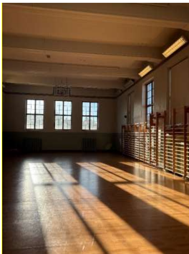
Figur 2. Vinduer i gymsalen på Skolen. Bilde tatt på befaring.
