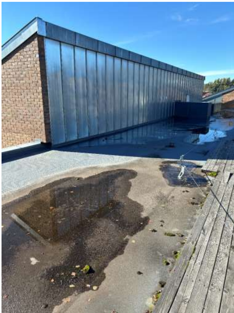
Figur 1. flatt tak på Omsorgssenter. Bilde tatt på befaring.
